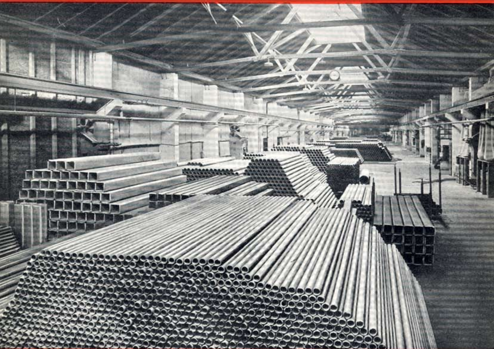
Mittelschiff der dreischiffigen Rohrhalle in Vöcklabruck
